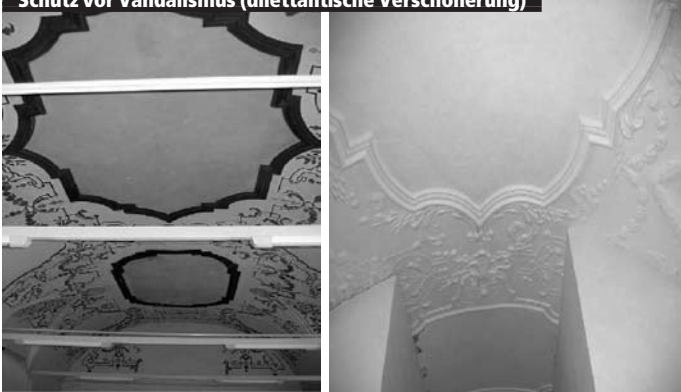
Schutz vor Vandalismus
